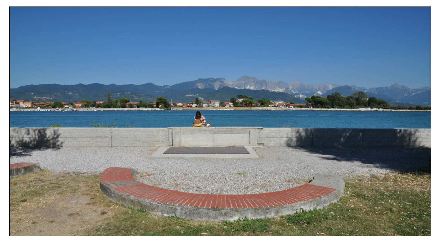
Seduta in muratura esistente
